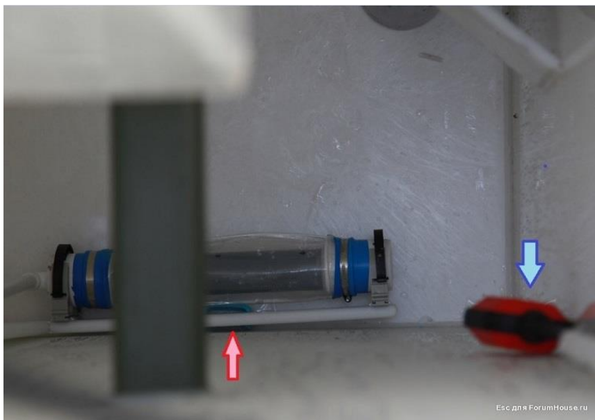
Рис. Приемная камера (L-образное крепление "Клюшка", Аэратор, "лягушка")
